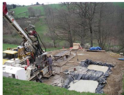
Sondage AB9 (2007) incliné de 45° de 125 m (surface plateforme estimée : 12 x 12 m soit environ 150 m²)
