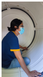
(a) Colocación de tyvek.
