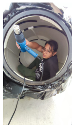
(b) Limpieza del tanque.
