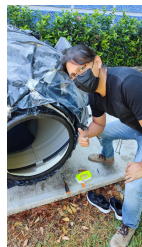
(e) Revisión del tanque.
